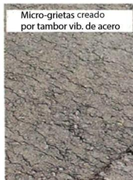
Fig.4 Elimina las micro-grietas creado en pavimento asfáltico
