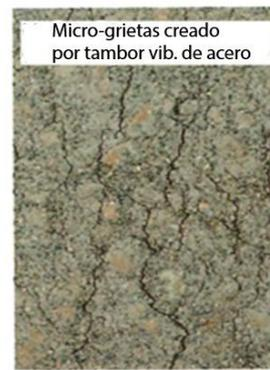
Fig.6 Sellado de superficie de pavimento de concreto hidráulico compactado por rodillo
